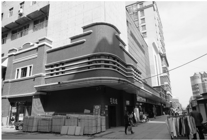
図 53. 長江路建造物（再現後）
