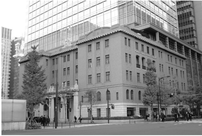
図 27. 日本工業倶楽部会館（復原後）
