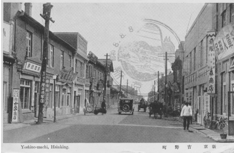
図 54. 吉野町建造物（再現後）
