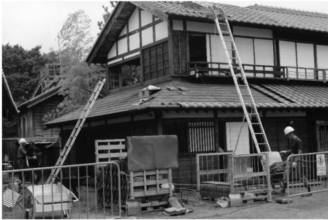
図 73. 改修工事風景
