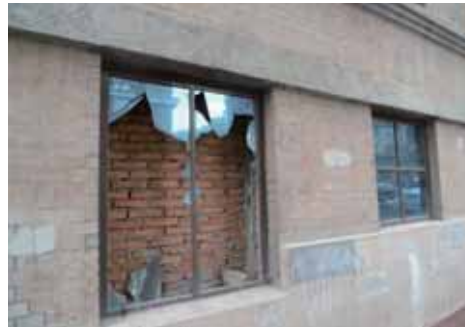
图70. 满州電信電話局改修部
