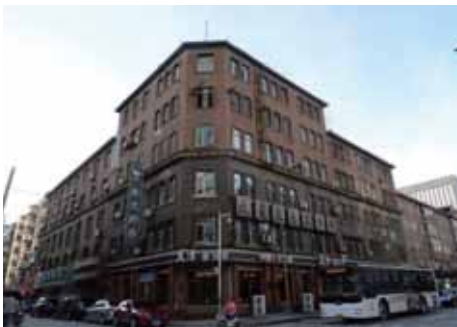
図99. 武田薬品奉天支店（複合ビル）
