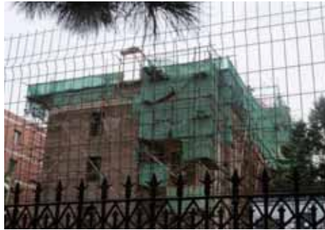
图34. 滿州国司法部改修工事
