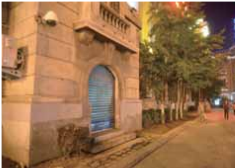
図139. シャッター改修部
