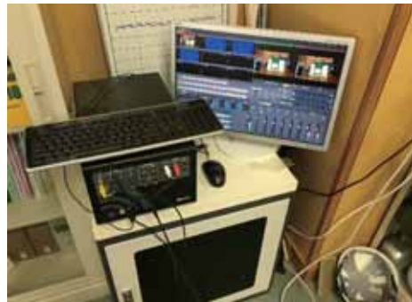
図78.機器接続状況
