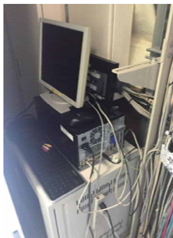
図28. TriCaster設置状況
