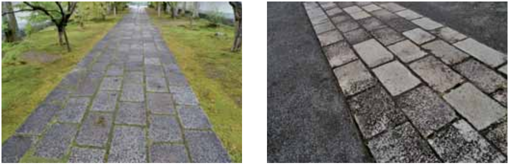
図7. 旧静岡市内線軌道礎石（新光明寺）
